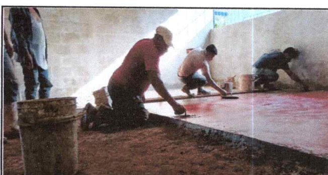
Foto 6: Se observan los trabajos de fundicion y alisado del piso de torta de concreto en las aulas.
