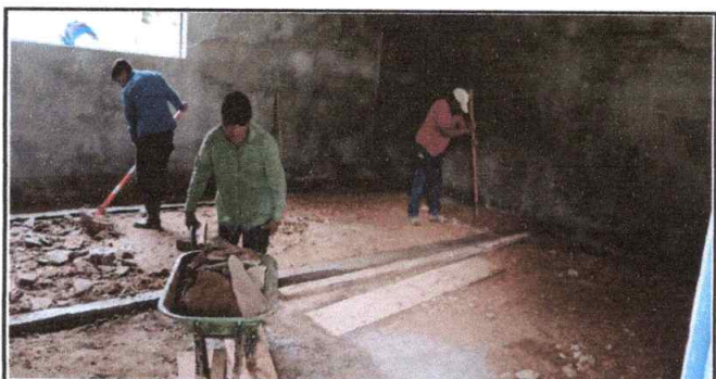
Foto 5: Trabajos de nivelacion y compactacion en el suelo de tierra del aula.
