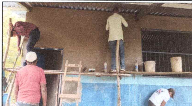
Foto 1: Se observan los trabajos de reparación de repello en paredes exteriores e interiores.
